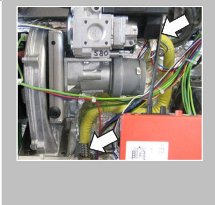
Compruebe la estanqueidad a los gases de las tuberías de gas, de las conexiones y de las tapas protectoras, desde la conexión del aparato hasta las válvulas reguladoras del gas.
